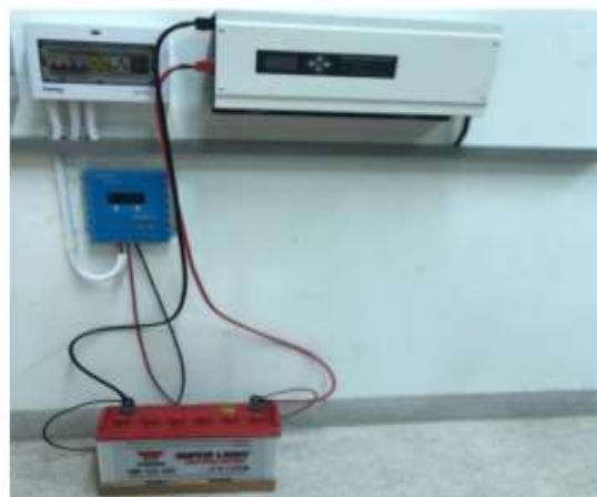
ภาพที่ 4: การชุดสาริตการติดตั้งโซลาร์เซลล์ระบบ ไฮบริด ขนาด 500 วัตต์
